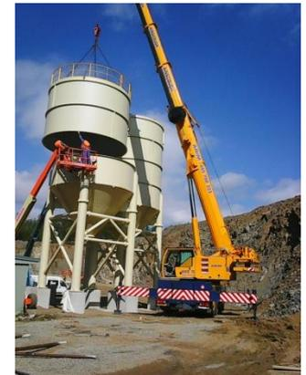
Steinbruch Štíleček, 2019: Gesamtvolumen von 3 Silos beträgt  $650 \text{ m}^3$ , Silodurchmesser 6 m, Höhe 16 m, Montage 3 Wochen.
